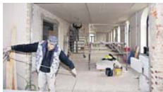
Bauarbeiten in der Empfangshalle.
