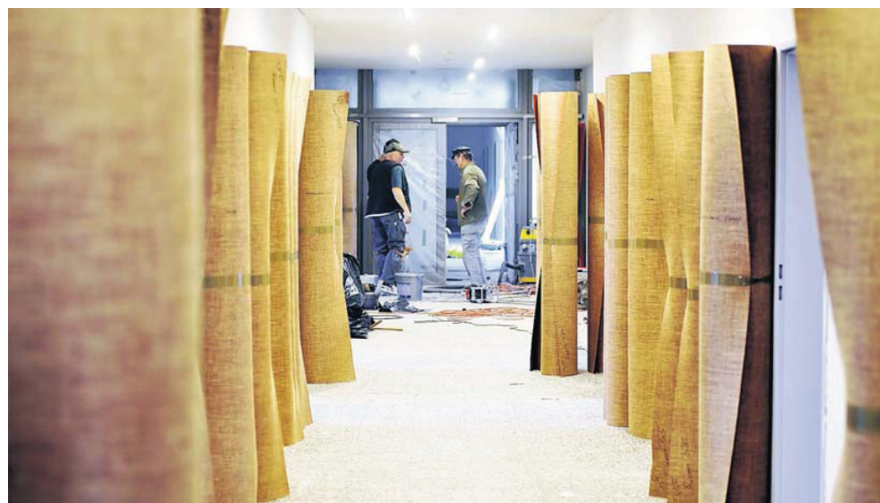
Die Linoleumrollen stehen schon bereit: In der obersten Etage des „Havenhostels“ sind die Sanierungsarbeiten am weitesten fortgeschritten. Sie ist komplett vom Alfred-Wegener-Institut (AWI) angemietet worden, um dort Teilzeitbeschäftigte unterzubringen.
